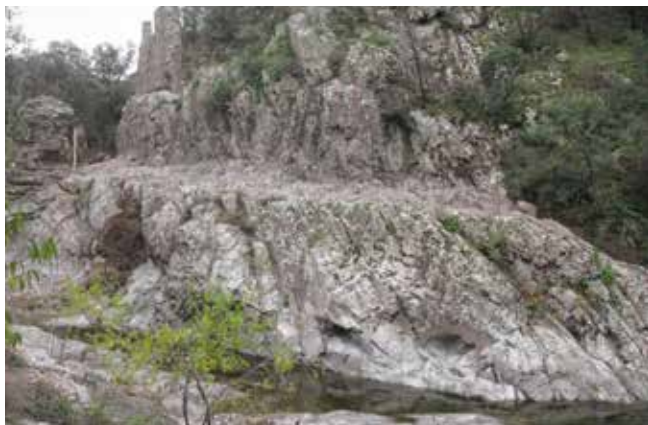
Figure 54 – Un ouvrage d'époque tardive sur le tracé de la voie Domitienne, la Porte des Cluses (Pyrénées-Orientales). Vue du passage en corniche pour l'accès à la tour-porche.
